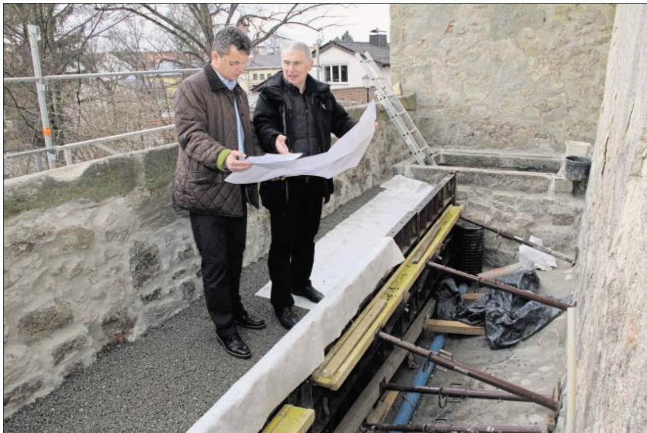
Architekt Michael Steidl (rechts) erläutert Bürgermeister Martin Birner die Arbeiten zur Stabilisierung der Zwingermauer an der Fronfeste. Im Graben wird in der Mitte ein Fußweg mit einer Schotterdecke eingebaut, beidseitige Graniteinzeiler sollen das Regenwasser in die Drainage ableiten. Bilder: Mardanow (3)
