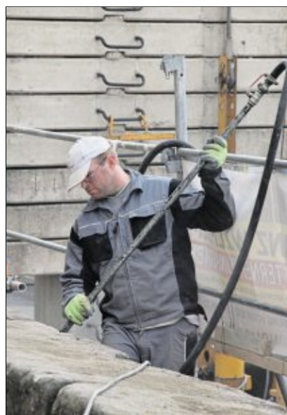
Die Mitarbeiter der Baufirma Wilhelm lassen die Zwingermauer wieder stabil dastehen.
